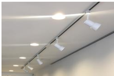
例)室内照明の設置
