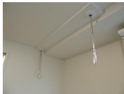
例)室内物干しの設置
